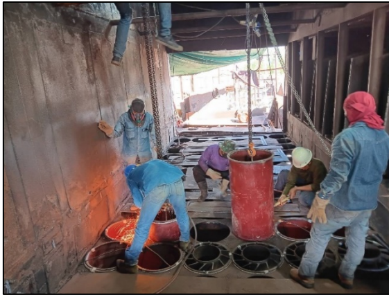
ภาพที่ 2.2-1 ระบบดักฝุ่นแบบมัลติไซโคลน
